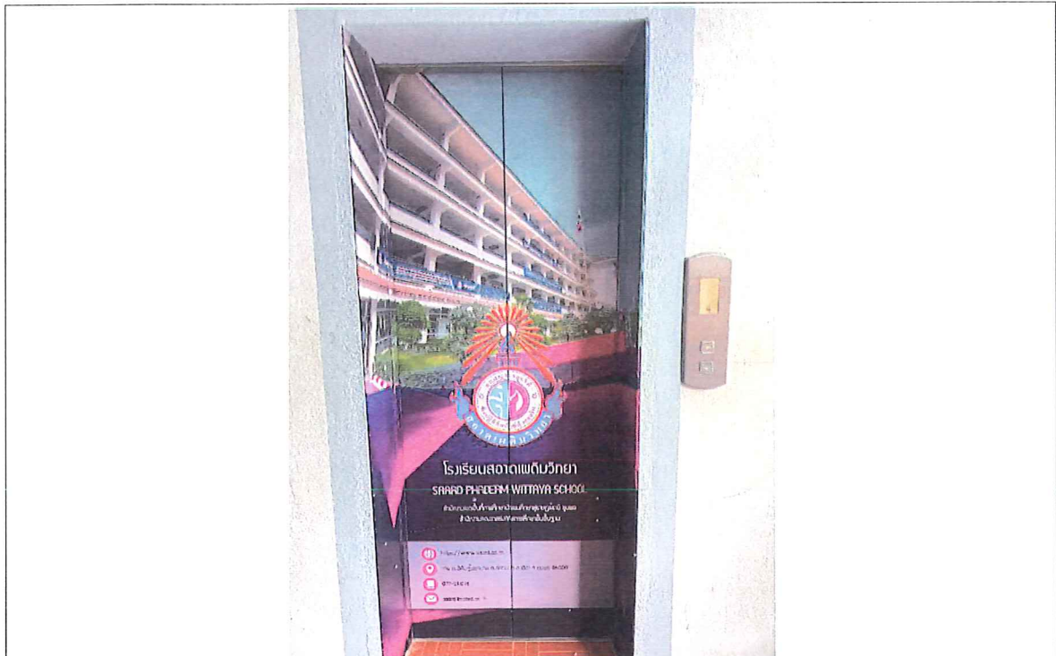
ติดสติ๊กเกอร์หน้าลิฟต์ เปลี่ยนปุ่มเรียกลิฟต์และจอแสดงผลชั้น
